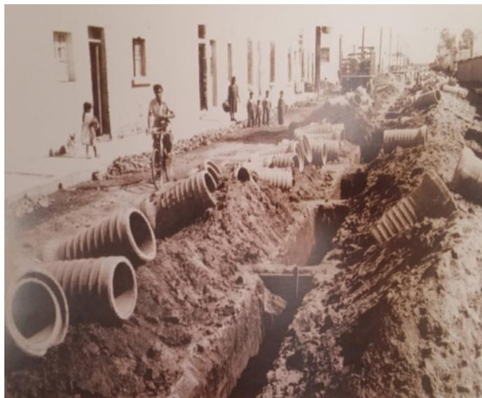
**Imagen 10.3:** Trabajos hidráulicos en diferentes zonas de la ciudad de Guadalajara imágenes extraídas de “Senderos de Agua y Concreto” en el AMG. Entubamiento en la colonia americana;
