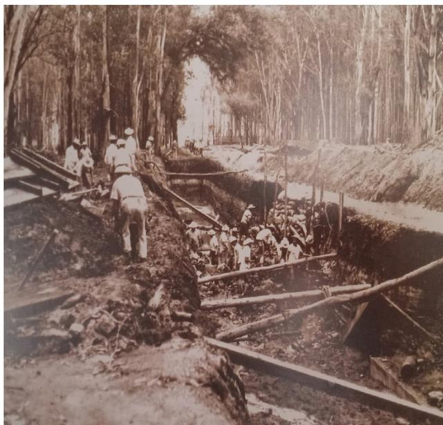
**Imagen 9.3.** Transformación del Agua Azul, imágenes extraídas de “Senderos de Agua y Concreto” en el AMG. Construcción de un colector
