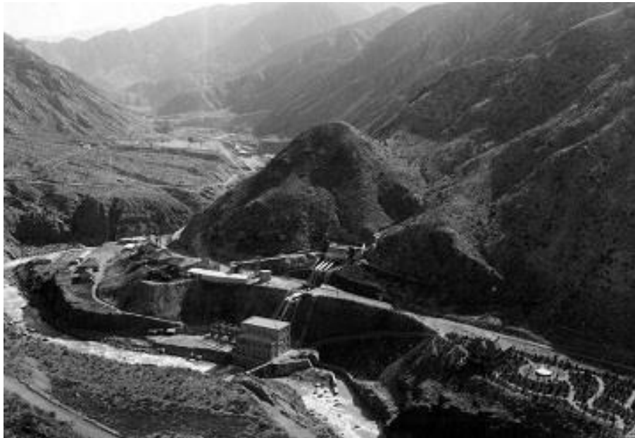
Figura 5: Vista general de la usina, el barrio obrero y chalet del personal jerárquico (1926c.). Galileo Vitali, Hidrología Mendocina: Contribución a su Conocimiento . (Mendoza: Talleres Gráficos D'Accurzio, 1940), 43.
