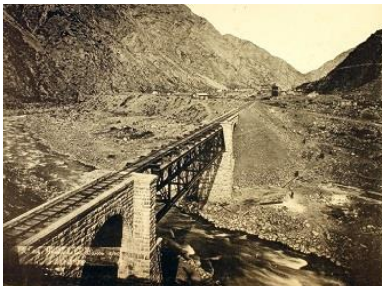
Figura 2: Puente ferroviario «los Baños» en el km 38,7 y vista hacia el sur del pueblo de Cacheuta (1907). Fuente: Colección Alex Gulliver, Archivo Nacional de Chile.
