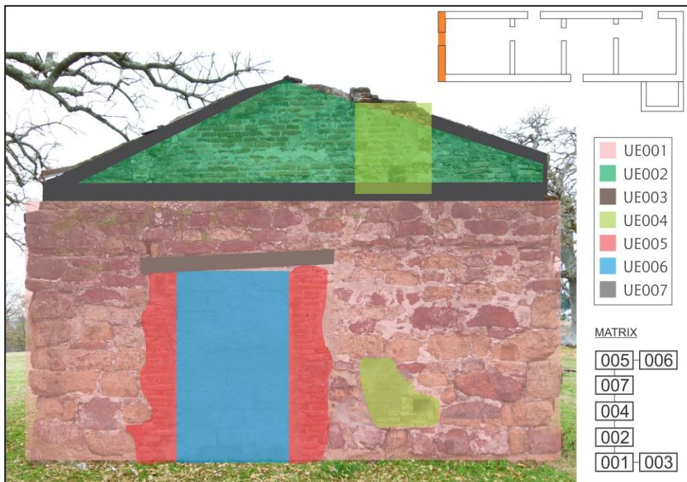
Figura 11. Unidades estratigráficas identificadas en el muro Noroeste.
