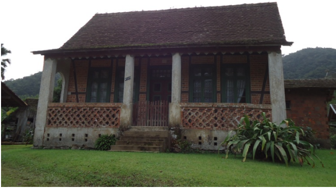
Figura Nº1: casa em técnica enxaimel (Testo Alto)
