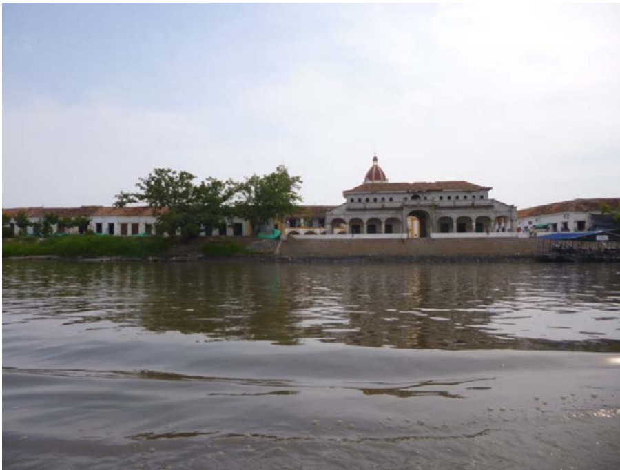
Figura N° 2. Visual del Antiguo Mercado de Mompox, desde el río. Autor: Mario Perilla.
