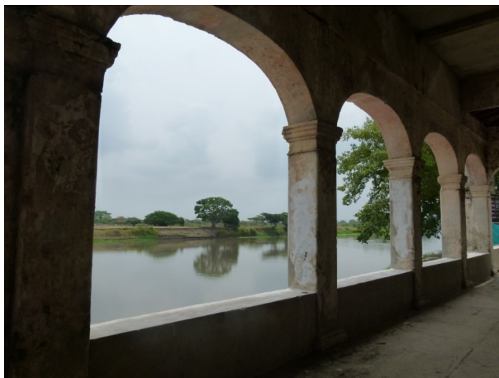
Figura N° 1. Portada hacia el río. Antiguo mercado de Mompox.
