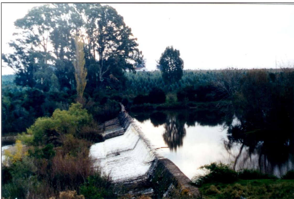
Figura 1 – Vista general del sitio. Fotografía tomada en julio de 1995.
