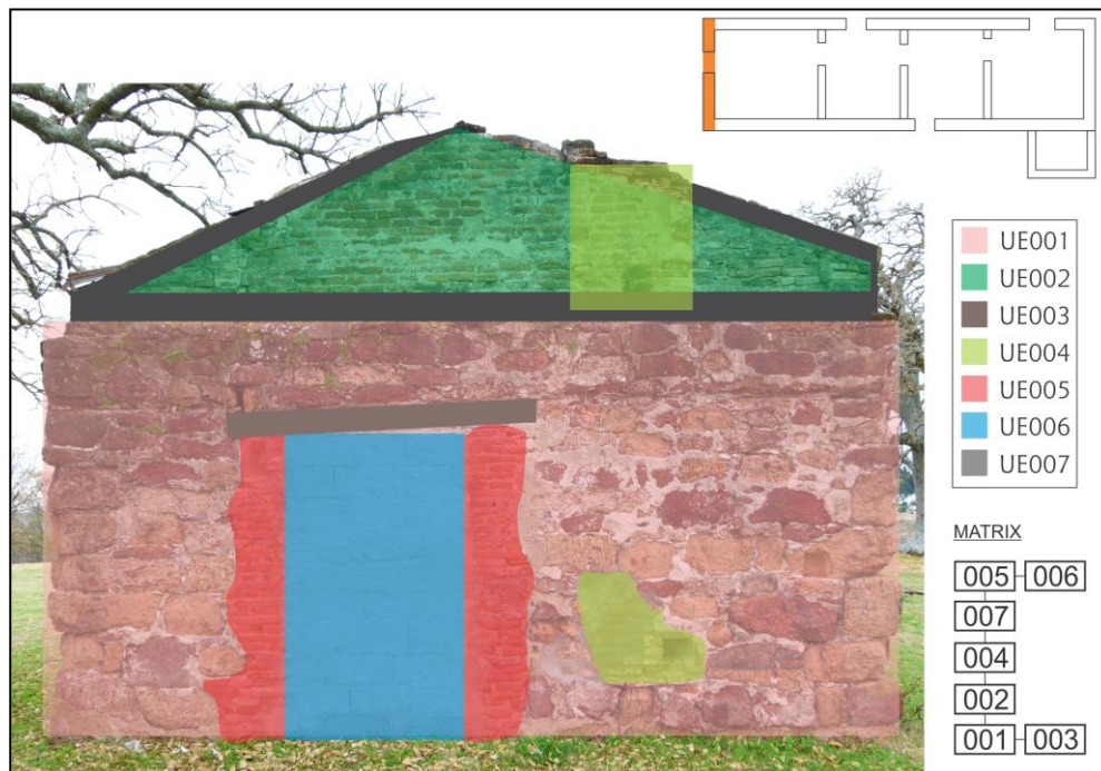
Figura 11. Unidades estratigráficas identificadas en el muro Noroeste.
