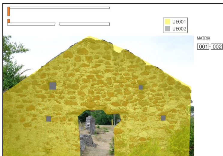
Figura 9. Fases constructivas correspondientes al siglo XVIII en el muro Suroeste.
