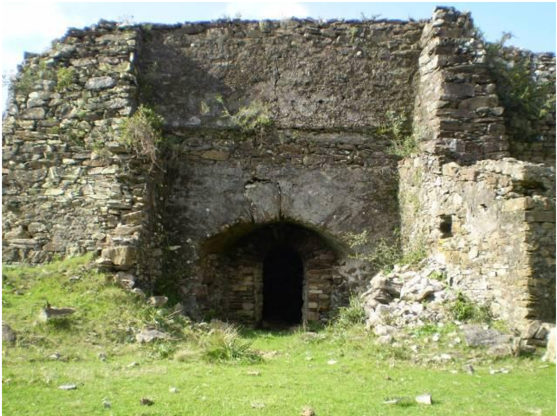
Figura 4 – Boca de descarga – Espacio frontal
