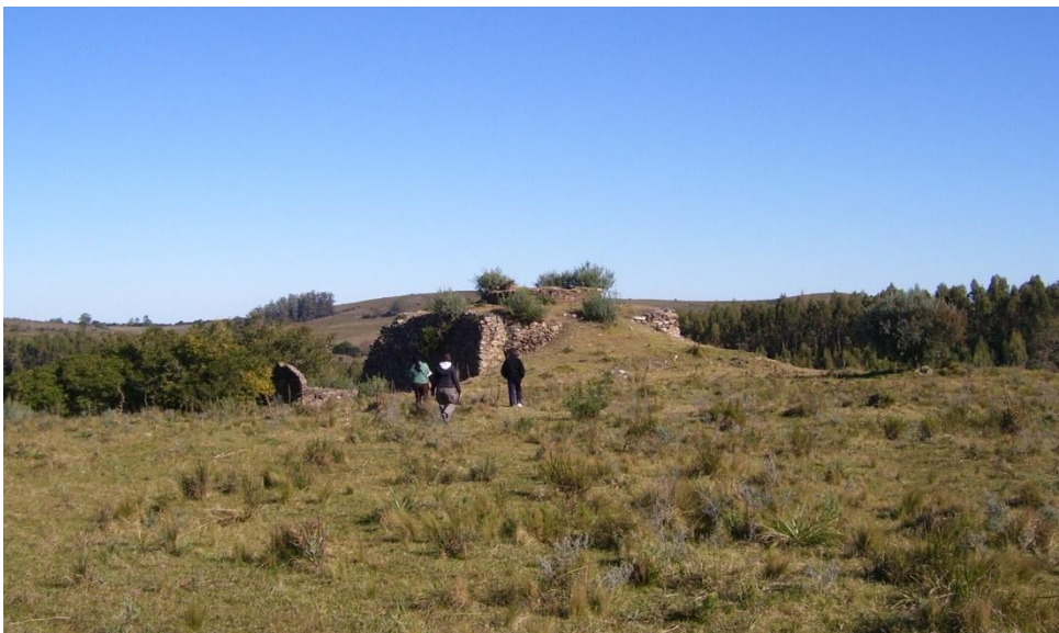
Figura 6 – Terraplén de acceso a la boca de carga
